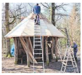
Das Dach der Hütte am Hasselsweg wurde neu eingedeckt (von links:) Georg Nover, Reinhold Thierse, Klaus Fietzek. FOTO: STEFAN WICHT
