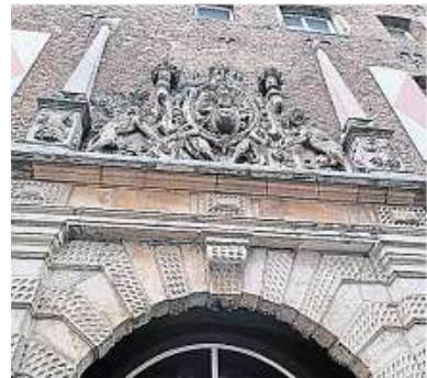
Das Portal an der Nordseite des Zeughauses. FOTO: STEP
