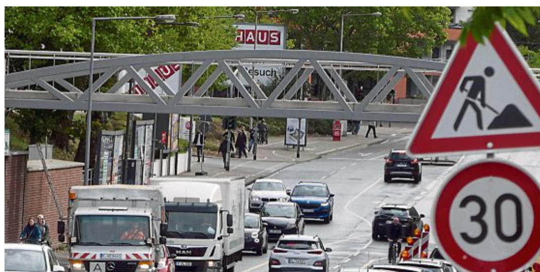
Eine neue Stahlbogenbrücke überspannt jetzt die Weinsbergstraße in Ehrenfeld. Freigegeben für den Fuß- und Radverkehr ist sie noch nicht. Foto: Rösgen
