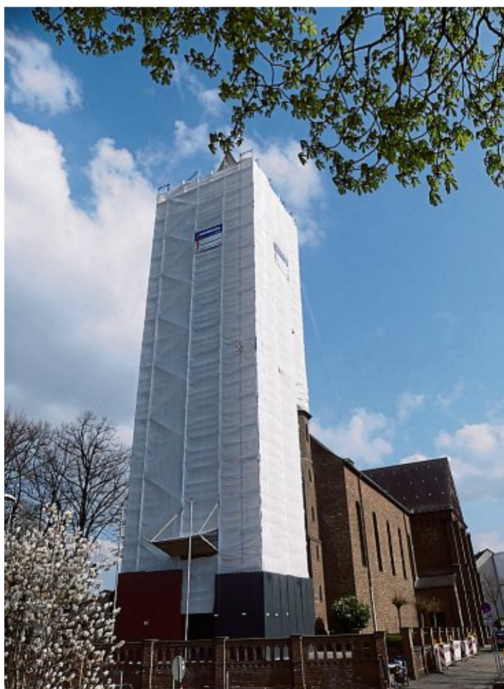
Der Turm der Kirche St. Rochus in Bickendorf ist eingerüstet. Foto: Rös
